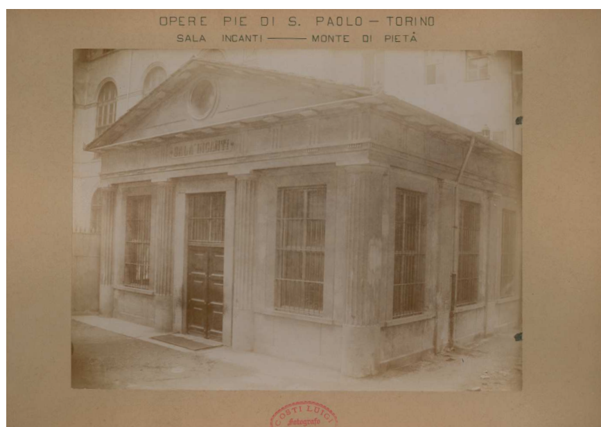
Auction room of the Monte di Pietà before the renovation, late 19th century. © Archivio Storico della Compagnia di San Paolo.
